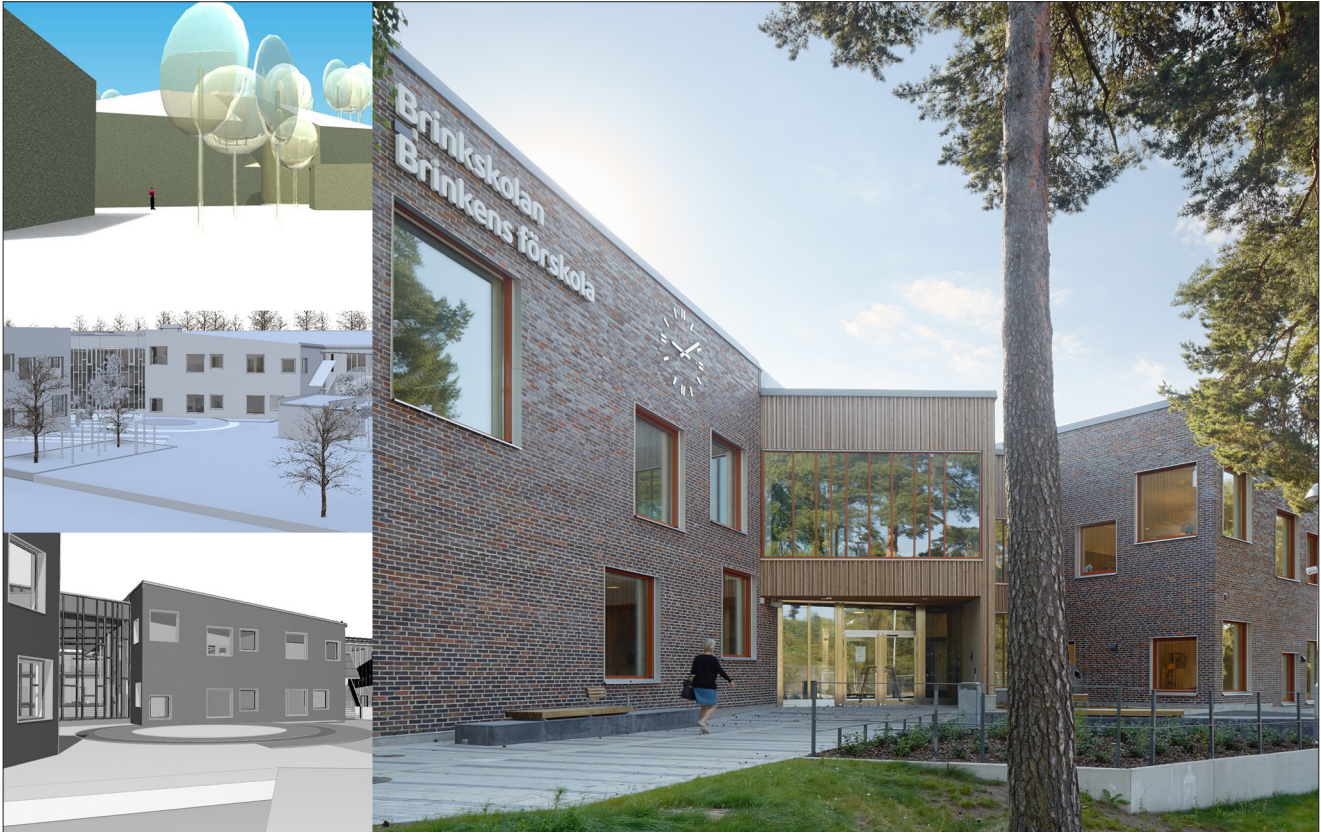
Utvecklingen av modell fram till färdig byggnad, Brinkskolan i Täby.
